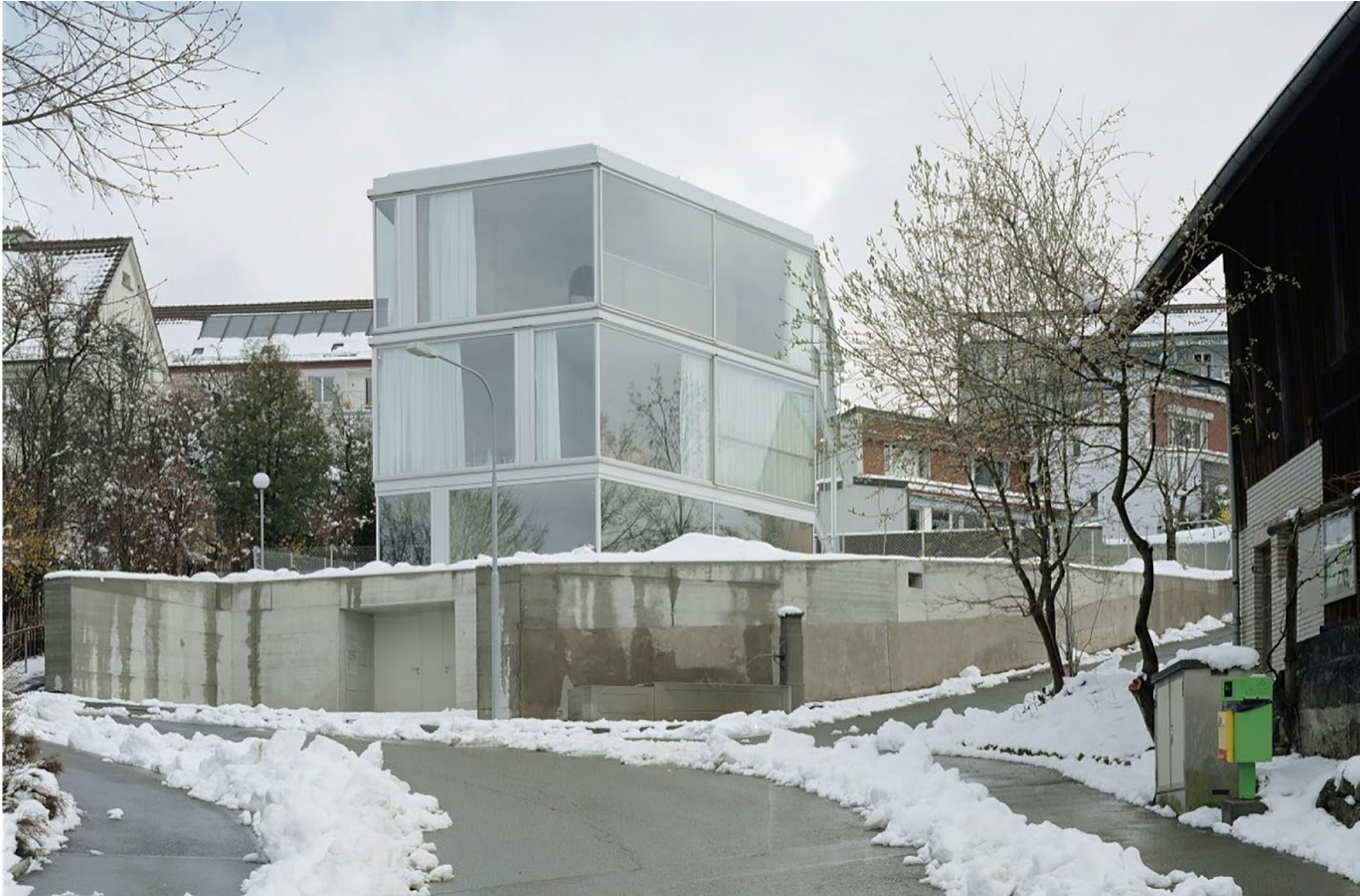
Das Haus mit einer Wand, Zürich, 2007, Arch.: Christian Kerez, Ing.: Joseph Schwartz
